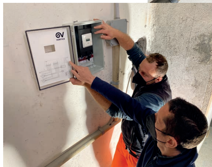
Installazione centralina SICURBOX di controllo, monitoraggio e gestione.
