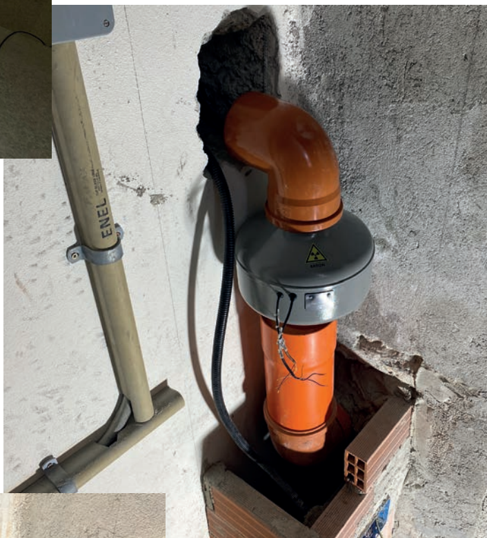
Installazione centralina SICURBOX di controllo, monitoraggio e gestione.
